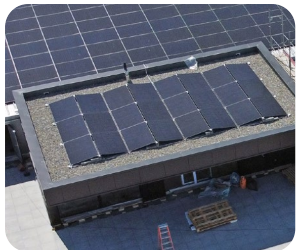
Toiture de la nouvelle cafétéria SCDI, 1678 Siviriez
