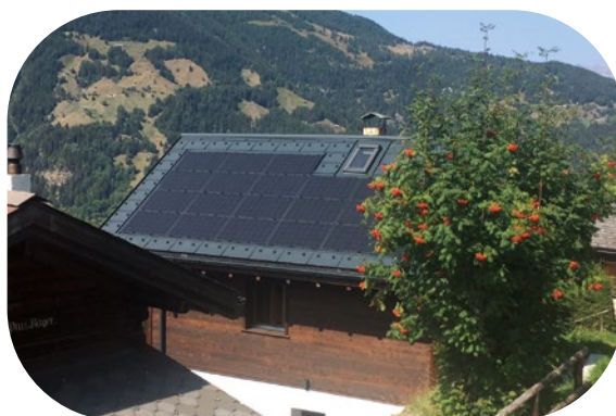
53 m 2 – 9.2 kWc - panneaux intégrés Solrif 3961 Vissoie
