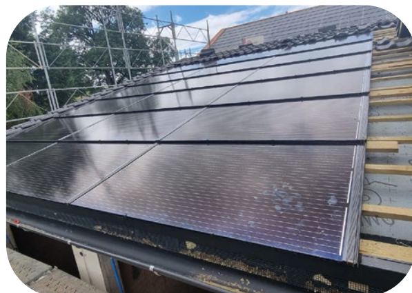
En cours de montage
