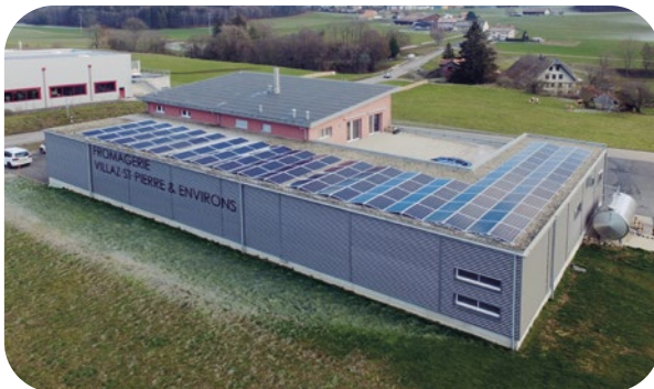
Fromagerie de Villaz-St-Pierre 44 kWc sur toiture plate
