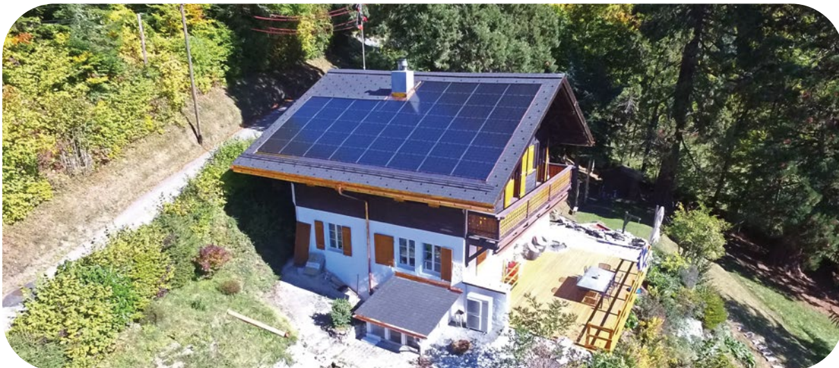
36 m 2 – 6.3 kWc - panneaux intégrés Solrif 1264 St-Cergue
