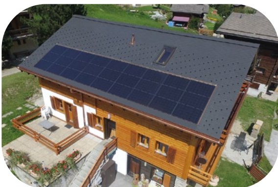
29 m 2 – 5.2 kWc - panneaux intégrés Solrif 3961 Grimentz
