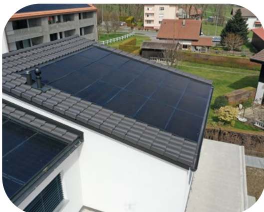
Exemple d'intégration à la toiture d'une villa neuve à 1681 Billens
