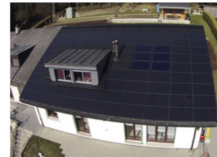
Villa dont la toiture a été totalement refaite avec des tuiles solaires MegaSlate II (1670 Ursy)
