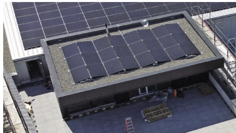
Toiture de la nouvelle cafétéria SCDI, 1678 Siviriez
