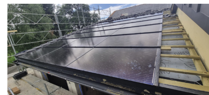
En cours de montage
