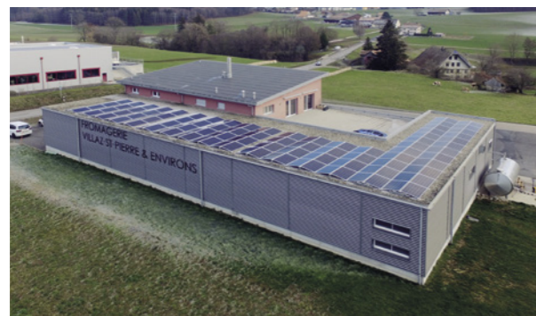
Fromagerie de Villaz-St-Pierre 44 kWc sur toiture plate
