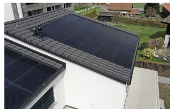
Exemple d'intégration à la toiture d'une villa neuve à 1681 Billens
