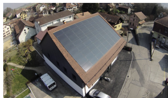
132 m 2 – 16 kWc 1523 Valbroye
